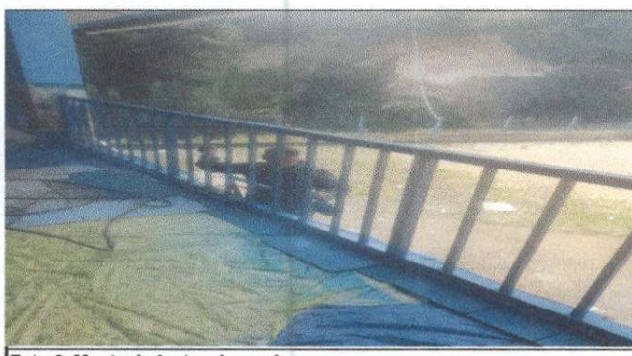
Foto 6. Mantenimiento a barandas
