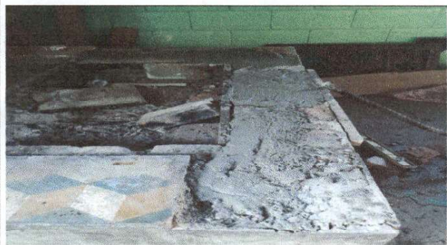
Foto 3. Sustitución y reparación de plancha en cocina
