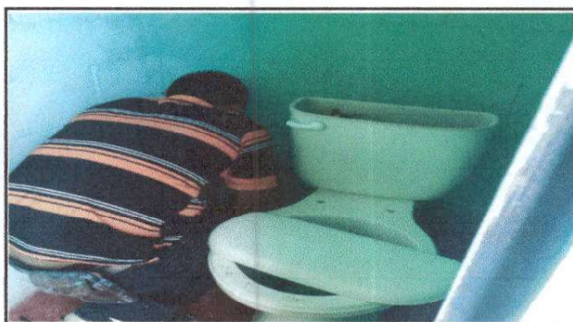
Foto 4. Instalación de accesorios en inodoros
