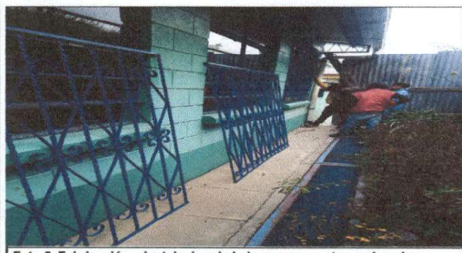
Foto 5. Fabricación e Instalación de balcones en ventanas de aulas
