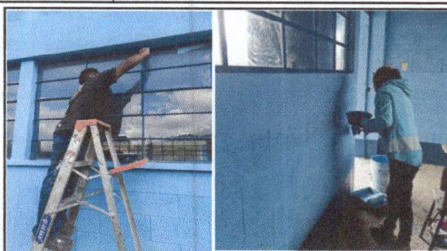
Foto 2. Pintura en muros exteriores e interiores
