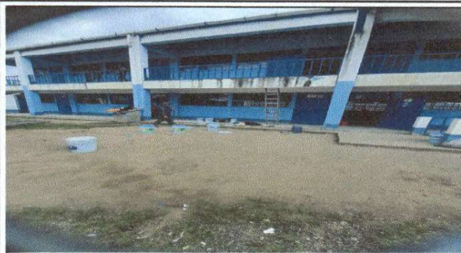
Foto 1. Mantenimiento a estructura de puertas (Reparación y Pintura)
